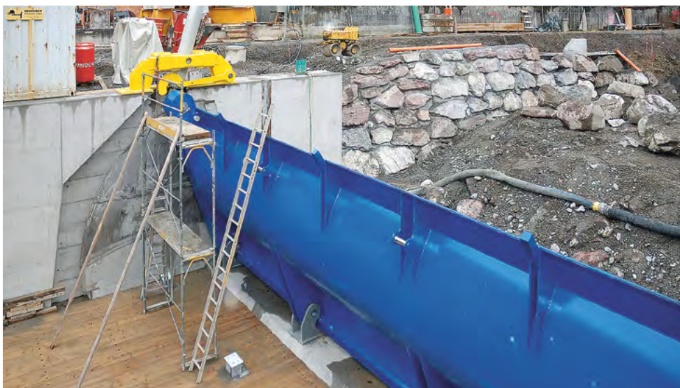
Einbau Wehrklappe Ost (W1)
