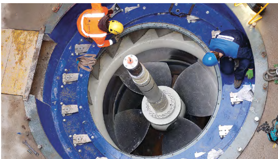
Einbau Turbinenlaufrad
